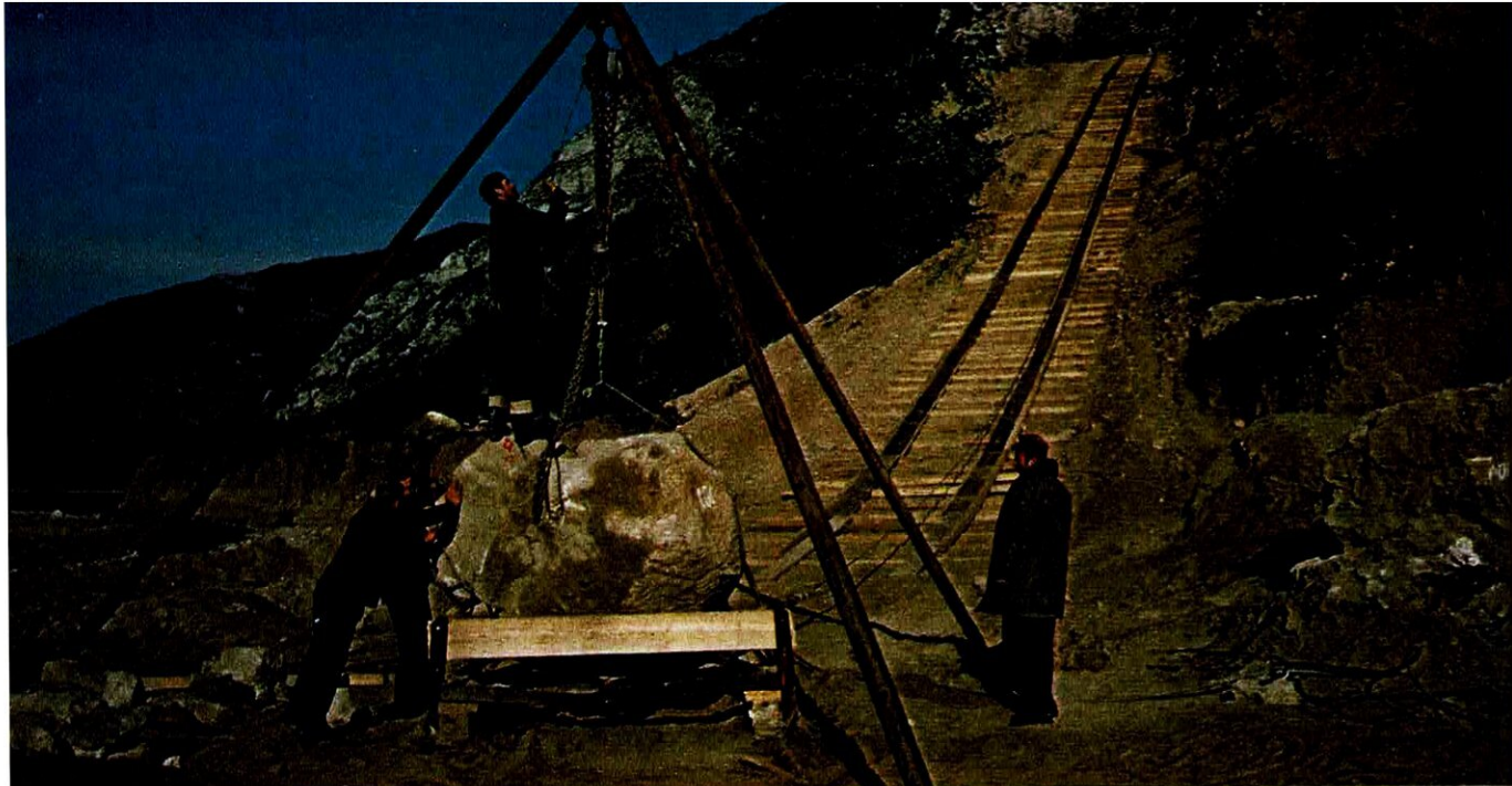
Cinquante-sept mètres de rails, d'un site à l'autre, pour permettre les opérations de levage.
