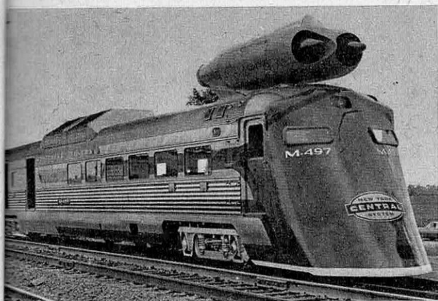
Là « M. 497 », construite par « New York Central System » est une automotrice équipée de 2 turboréacteurs « General Electric ». Elle a réalisé 295,8 km/heure en juillet dernier.
