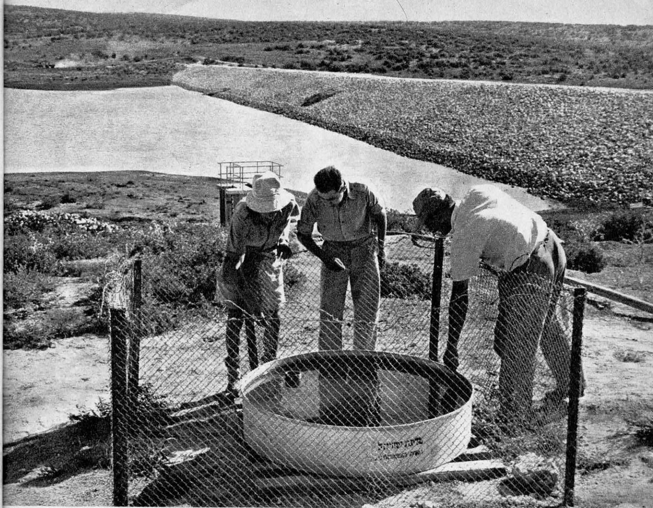
*Dans le désert du Neguev on mesure l'évaporation de l'eau au millimètre près.*
