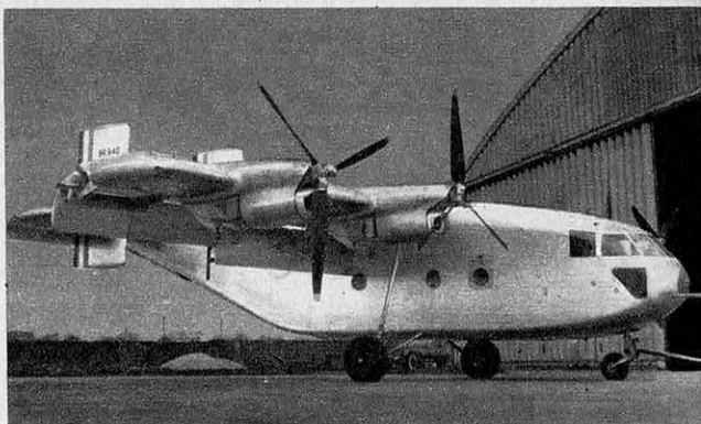
Le Breguet Intégral est le premier avion à ailes soufflées construit depuis la guerre. Une série en a été commandée par les pays atlantiques.
