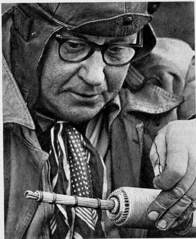
En pleine tempête l'équipe de Monistrol d'Allier est venue remplacer des manchons éclatés sur une ligne 225 kV.
