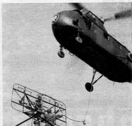
**3** La grue volante s'élève. Elle doit se mettre exactement à la verticale de la tour pour éviter tout balancement dangereux. La radio la guide toujours.
