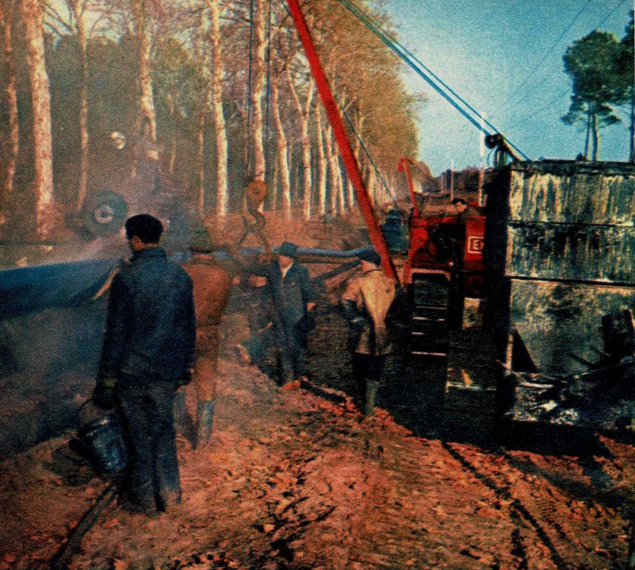
DANS LA FORET LANDAISE, LA POSE DU FEEDER QUI CONDUIT LE GAZ VERS LE NORD.
