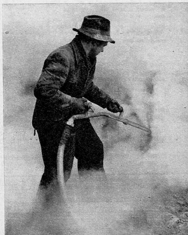
La lance à jet de vapeur est utilisée pour dégeler le gravier et le sable agglomérés par le gel. Les hommes profitent de cette chaleur.
