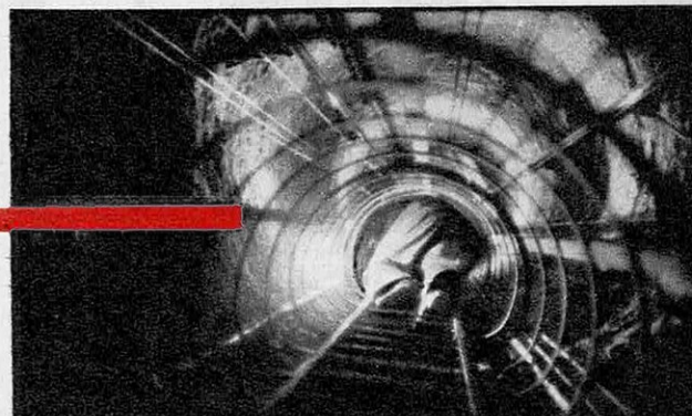
UN ASCENSEUR , doublé d'une échelle, permet de descendre dans le fond du puits.
