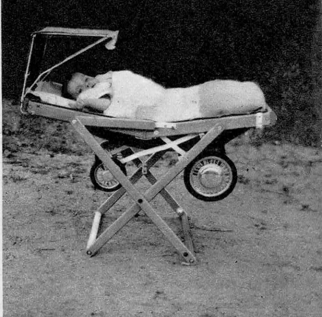
LE LIT SUR PIED : une même sangle sert à attacher l'enfant et à maintenir la poussette pliée.
