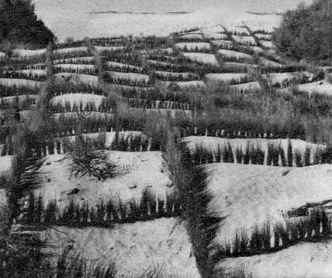
En Lybie, des juncos , plantés en carrés, sont un moyen d'empêcher l'invasion des dunes de sable. Il est employé près de Tripoli.
