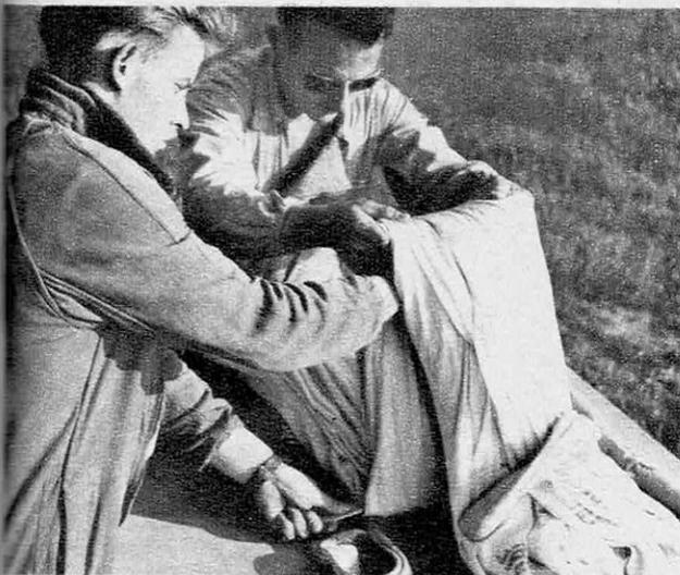
**4** La voileure, préparée et amenée en accordéon, recouvre le fond du sac et ses suspentes.
