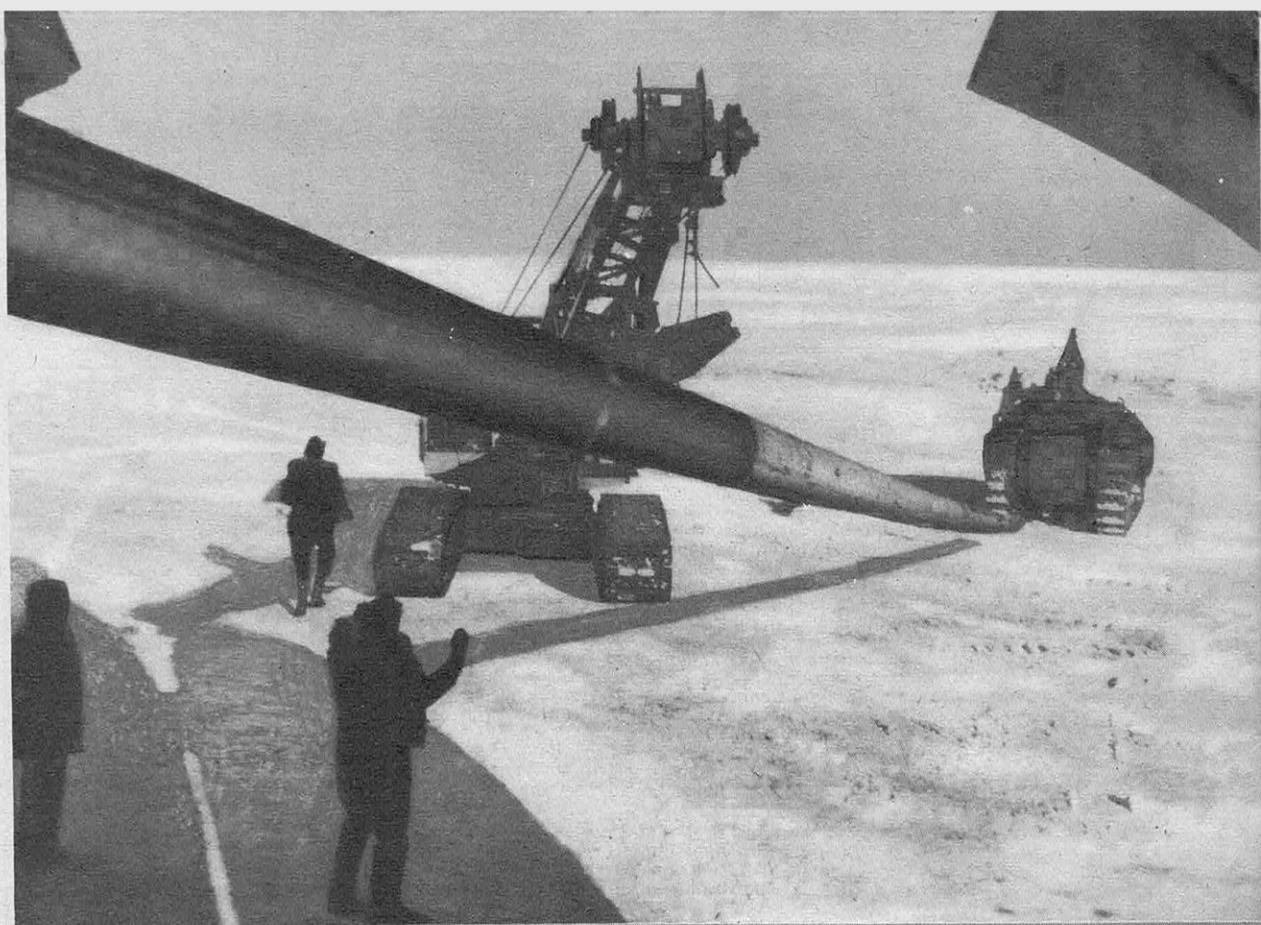
UN MAT, QUI SUPPORTERA UNE ANTENNE ÉMETTRICE, EST DÉCHARGÉ D'UN AVION-CARGO
