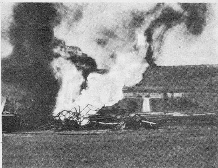
Le puits n°4 de Saint-Marcet connu aussi l'incendie. La photo a été prise le 15 juin 1941, aussitôt après l'écroulement du derrick. Le puits a pu être sauvé et il a actuellement un débit de 500 000 m 3 de gaz par jour.
