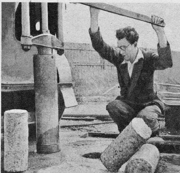
● Prélèvement d'échantillons renseignant sur la structure exacte d'une route en béton. Ces « carottes » sont ensuite soumises à des épreuves de résistance.
