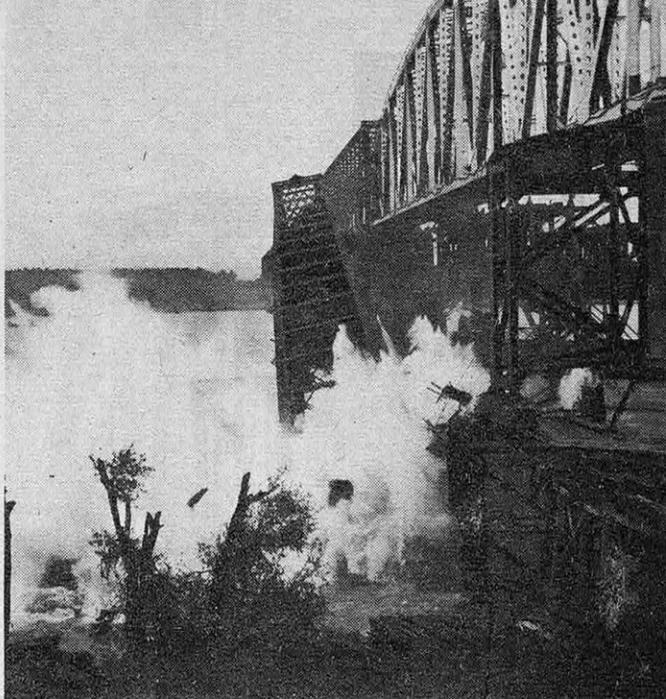
**LA CHUTE DANS LE FLEUVE.** — Après qu'on en a arraché les rails et les attaches, la carcasse est précipitée à l'eau. La parole est aux démolisseurs. « Sic transit... »
