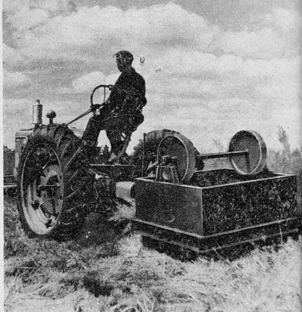
Débroussailluse employée dans la forêt landaise pour le nettoyage des sous-bois et des tranchées anti-feu.
