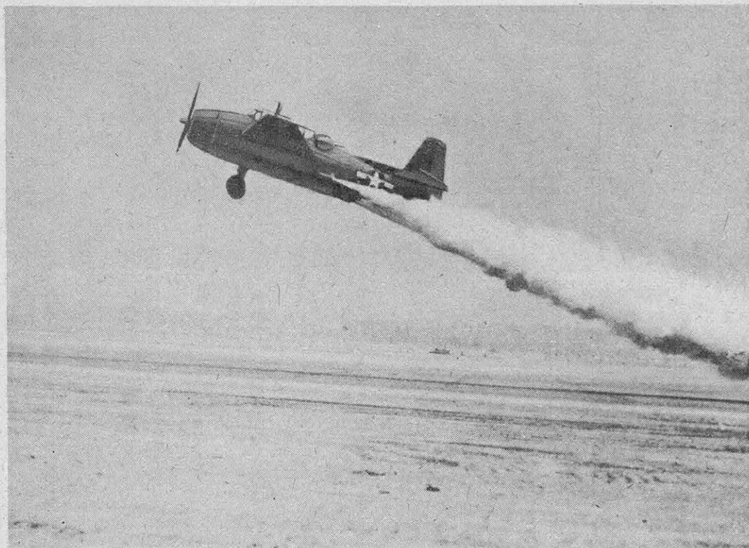
FIG. 7. — L'ENVOL D'UN BOMBARDIER TORPILLEUR AMÉRICAIN GRUMMAN TBF « AVENGER » A L'AIDE DE FUSÉES J. A. T. O.
