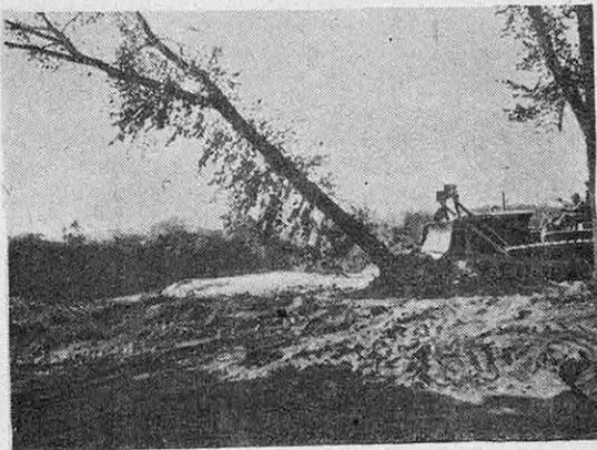
FIG. 4 ET 5. — ABATAGE D'UN ARBRE PAR POUSSÉE (A GAUCHE) ET PAR ARRACHAGE (A DROITE) (PHOTO LE TOURNEAU)
