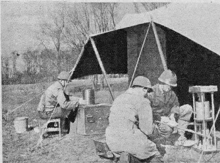
FIG. 2. — UN LABORATOIRE D'ANALYSE DU SOL ET D'ESSAIS MÉCANIQUES
