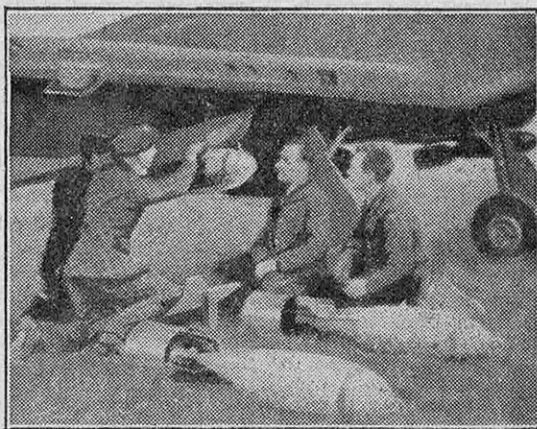
FIG. 5. — INSTALLATION DE BOMBES DE 125 KG SOUS L'AILE D'UN BOMBARDIER LÉGER « HURRIBOMBER » DÉRIVÉ DU HAWKER « HURRICANE »
