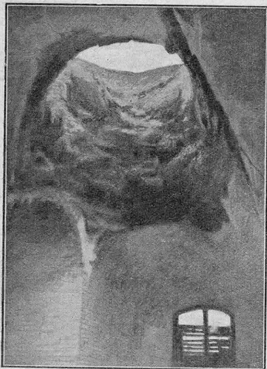
FIG. 1. — EFFET D'UN PROJECTILE ALLEMAND DE 420 MM FRAPPANT LA COUPOLE BÉTONNÉE D'UN FORT BELGE AU COURS DE LA GUERRE DE 1914
