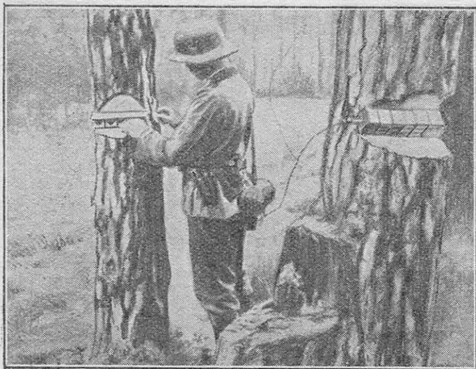
FIG. 3. — ARBRES MINÉS PAR UN SOLDAT DU GÉNIE
