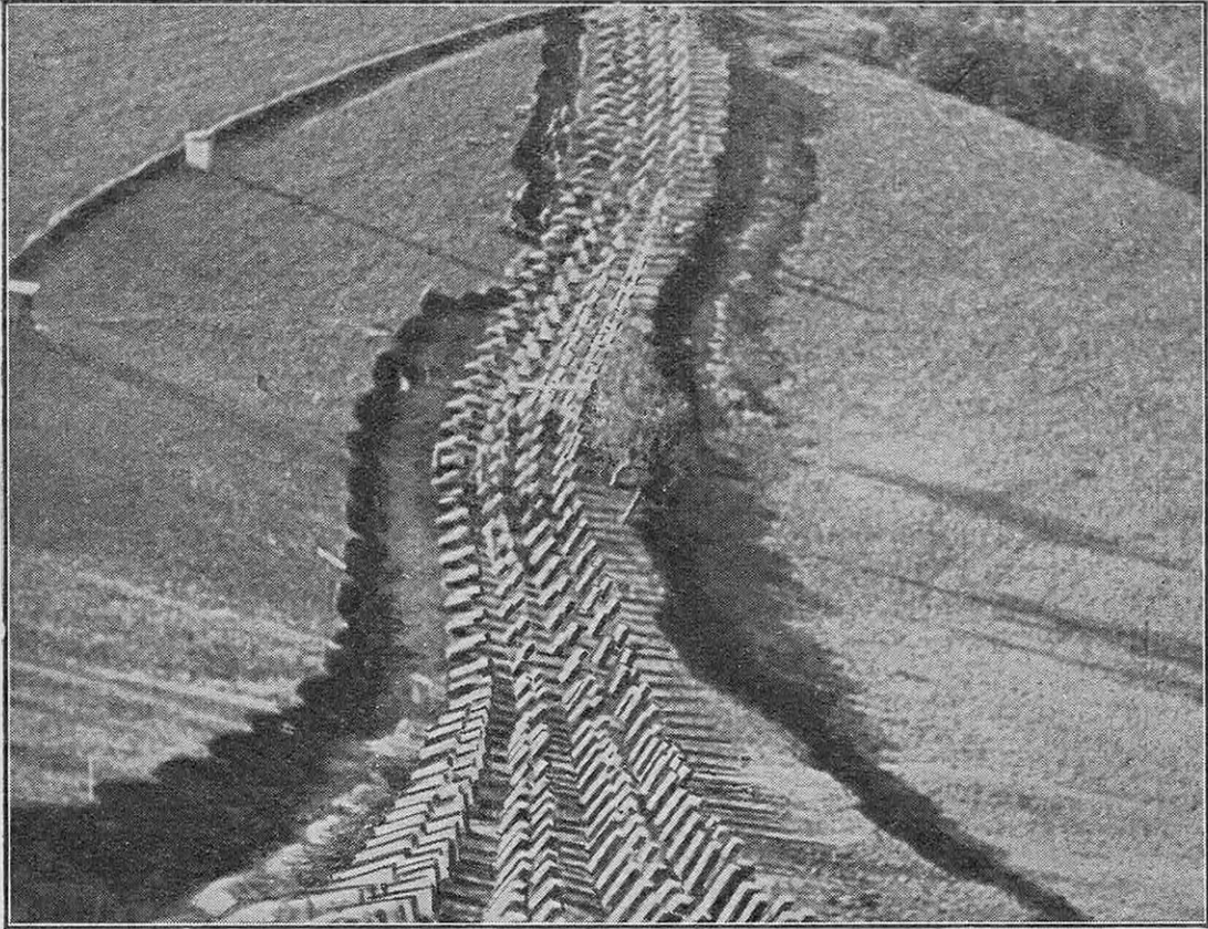
FIG. 11. — BARRAGE ANTICHARS EN DENTS DE BÉTON
