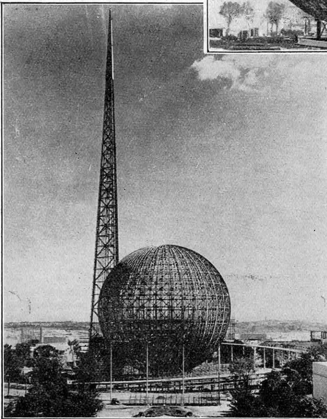
FIG. 4. — LES ARMATURES DE MÉTAL DU « TRYLÔNE » ET DE LA « PÉRISSPHERE » SANS LE REVÊTEMENT DE STAFF
