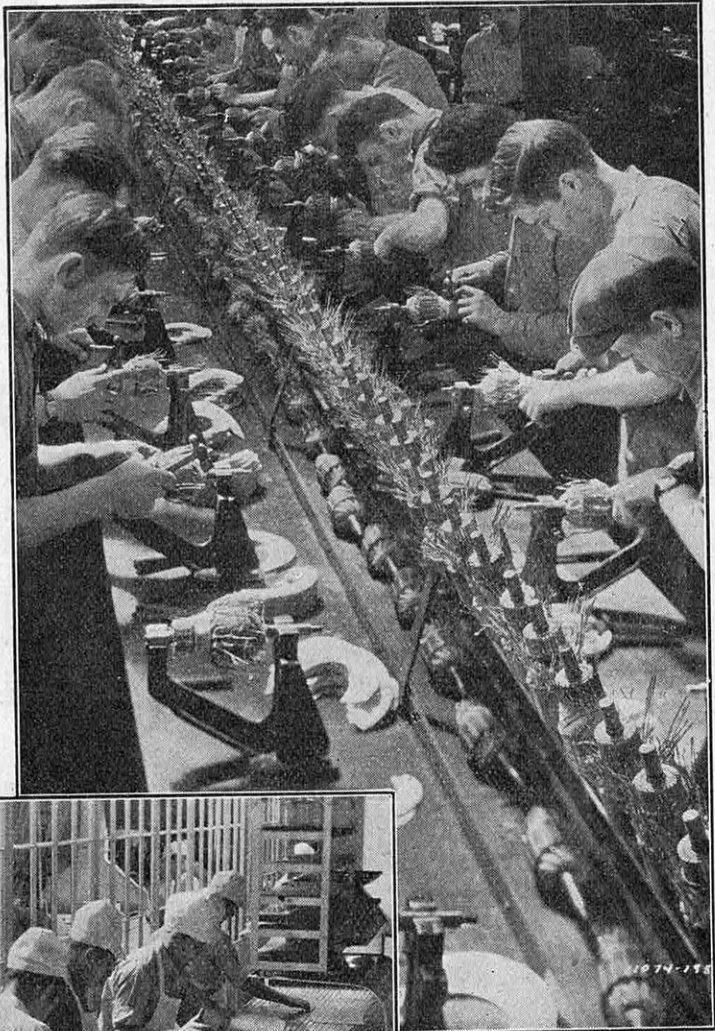
FIG. 8. — LA CHAÎNE DE MONTAGE DES INDUITS DE DYNAMOS CHEZ FORD
