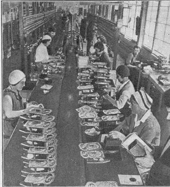
FIG. 5. — VUE D'UN ATELIER DE MONTAGE A LA CHAINE DES HORLOGES A L'USINE N° 2 DE MOSCOU
