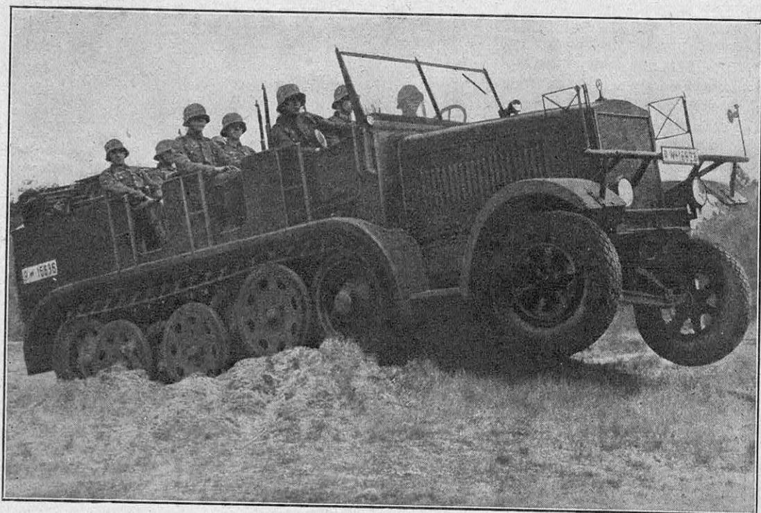
FIG. 4. — TRACTEUR A CHENILLES « TOUS TERRAINS » CONÇU POUR REMORQUER, SUR LES TERRAINS LES PLUS VARIÉS, LES PIÈCES DE 15 CM (VOIR LA PAGE PRÉCÉDENTE)
