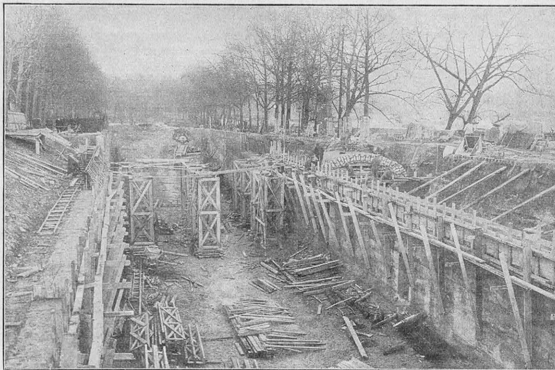
FIG. 3. — CONSTRUCTION DU PASSAGE SOUTERRAIN DU QUAÏ DE TOKIO
