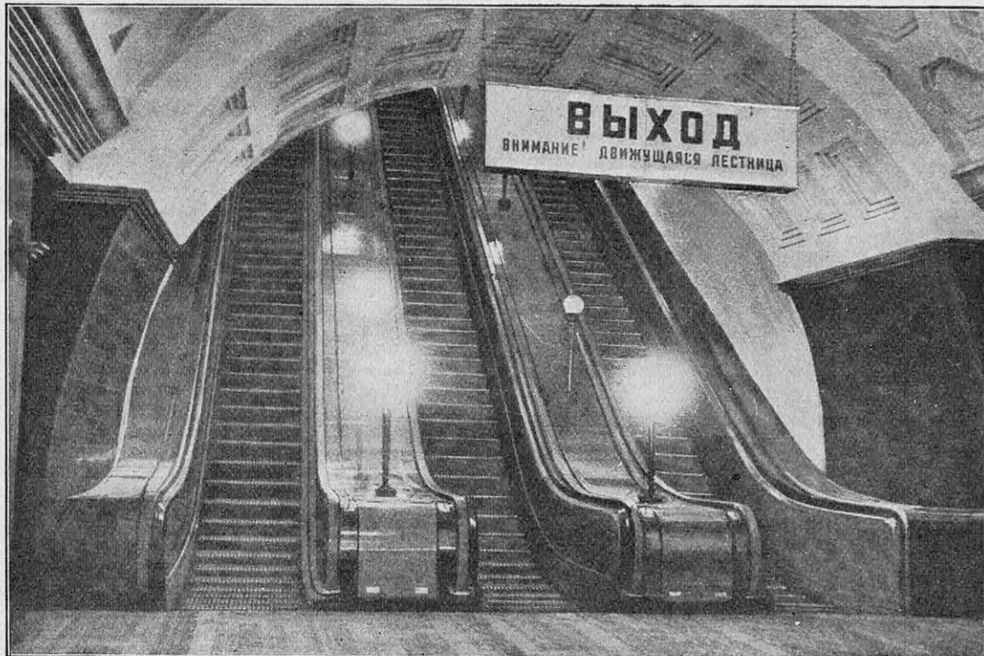
FIG. 1. — LES ESCALIERS MÉCANIQUES DE LA STATION « PORTE ROUGE » DU MÉTRO DE MOSCOU SONT DU MÊME TYPE QUE CEUX DU MÉTRO DE PARIS
