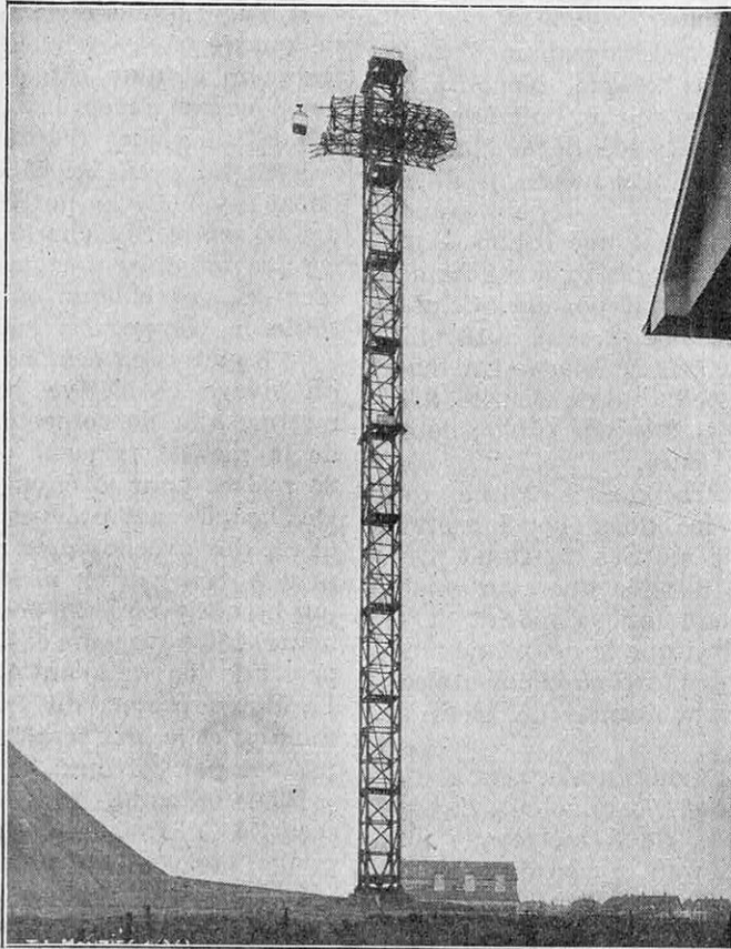
FIG. 10. — PYLÔNE TERMINANT UN TÉLÉPHÉRIQUE « MONZIÈS » POUR LA MISE EN « TERRIL », C'EST-A-DIRE POUR LE STOCKAGE EN TAS DE DÉCHETS D'INDUSTRIES
