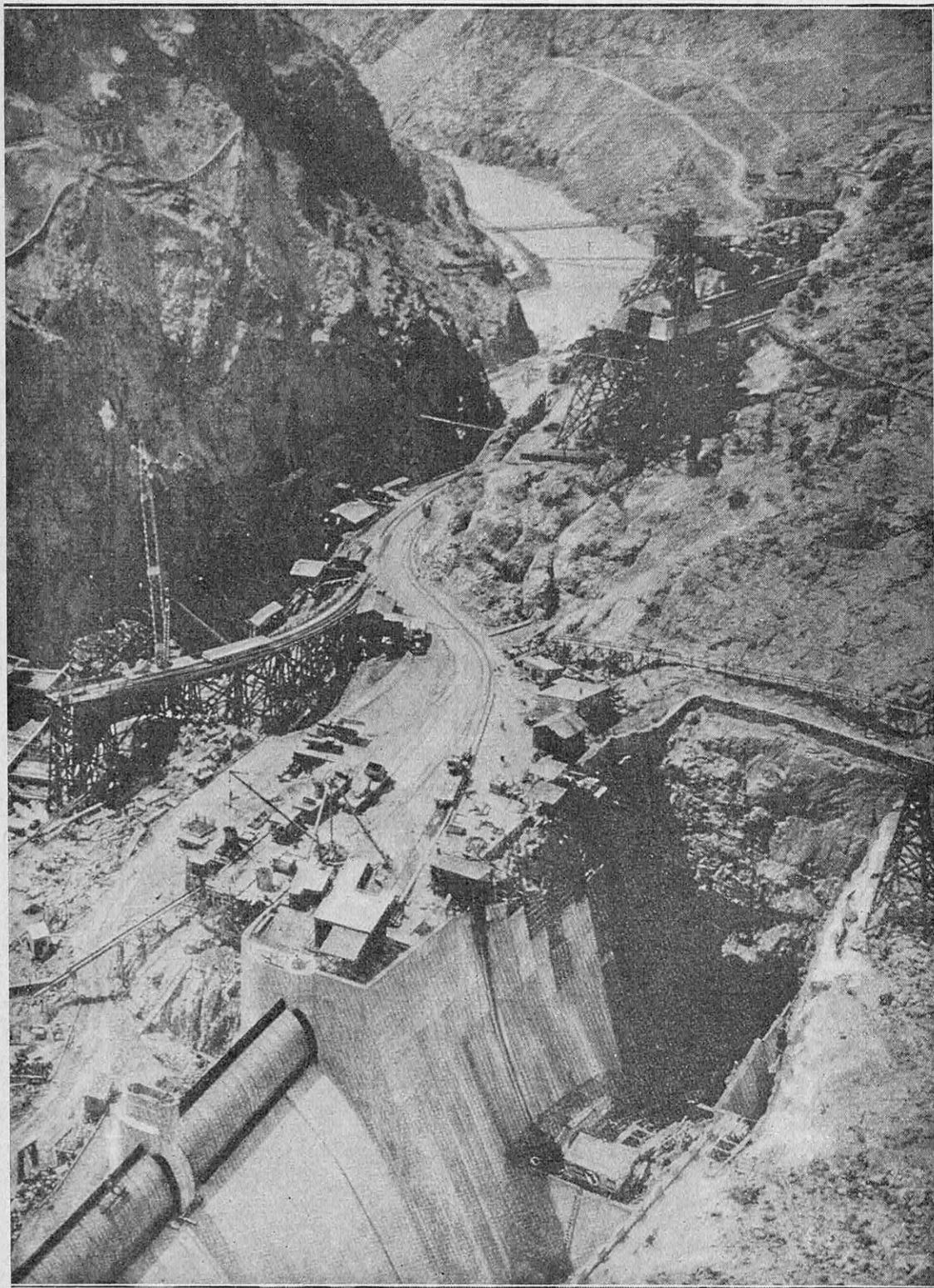
DU « BOULDER DAM », EN TRAVERS D'UNE DES CÉLÈBRES GORGES (CANYONS) DE CE FLEUVE 160 kilomètres de long (34 milliards de mètres cubes). A gauche, deux des quatre tours de prise d'eau de ch, située au pied du barrage. Au fond, on aperçoit le Colorado qui, pendant les travaux, a été dévié plusieurs milliers de kilomètres carrés et d'alimenter 5 millions d'individus en eau potable.
