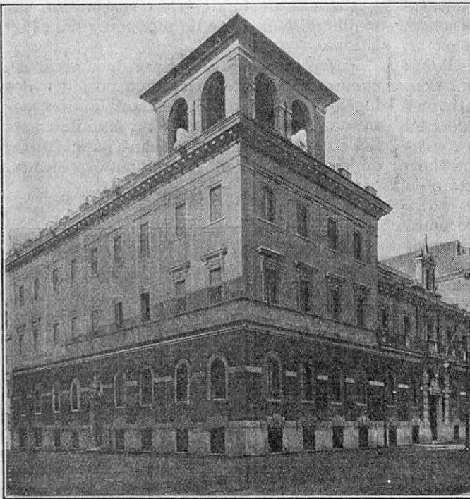
FIG. 4. — LE PALAIS DE LA RADIO A ROME Sept studios différents, acoustiquement isolés de façon absolue, sont prévus pour les divers genres de concerts exécutés.
