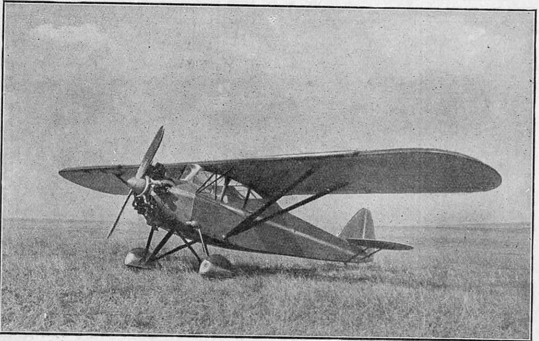
FIG. 4. — LE « POTEZ 43 », TYPE D'APPAREIL FRANÇAIS QUI RÉUNIT DES CONDITIONS DE SÉCURITÉ TOUT A FAIT INTÉRESSANTES A CELLES D'UNE TRÈS GRANDE FACILITÉ DE PILOTAGE ET QUI CONSTITUE UN DES TYPES LES PLUS ACCOMPLIS DE L'AVION DE TOURISME. La vitesse réelle de l'appareil pourrait peut-être laisser à désirer, bien qu'elle représente un gros progrès sur celle du Potez 36, frère aîné du 43. Le moteur du Potez 43 est un Potez 100 ch.
