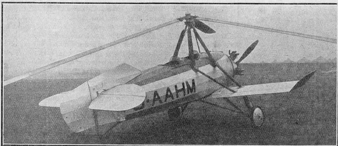
FIG. 1. — MODÈLE D'AUTOGIRE AVEC PLANS INFÉRIEURS ET DÉFLECTEURS
