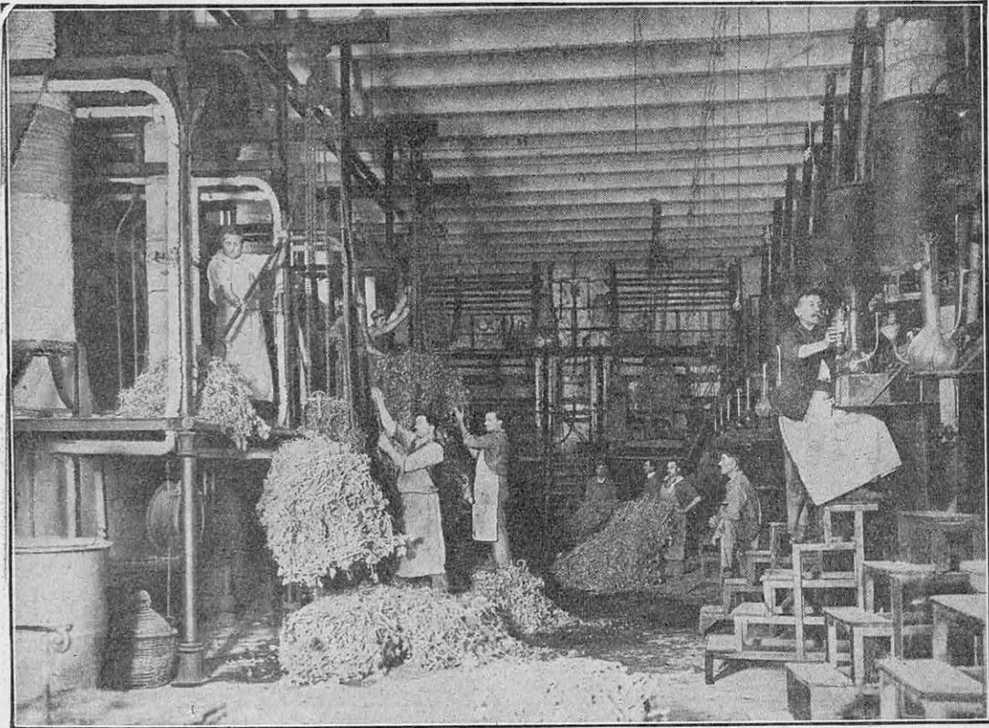
FIG. 5. — SALLE OU L'ON OPÈRE LA DISTILLATION DU GÉRANIUM « ROSAT », DANS UNE DES MULTIPLES ET IMPORTANTES USINES DE LA RÉGION DE GRASSE
