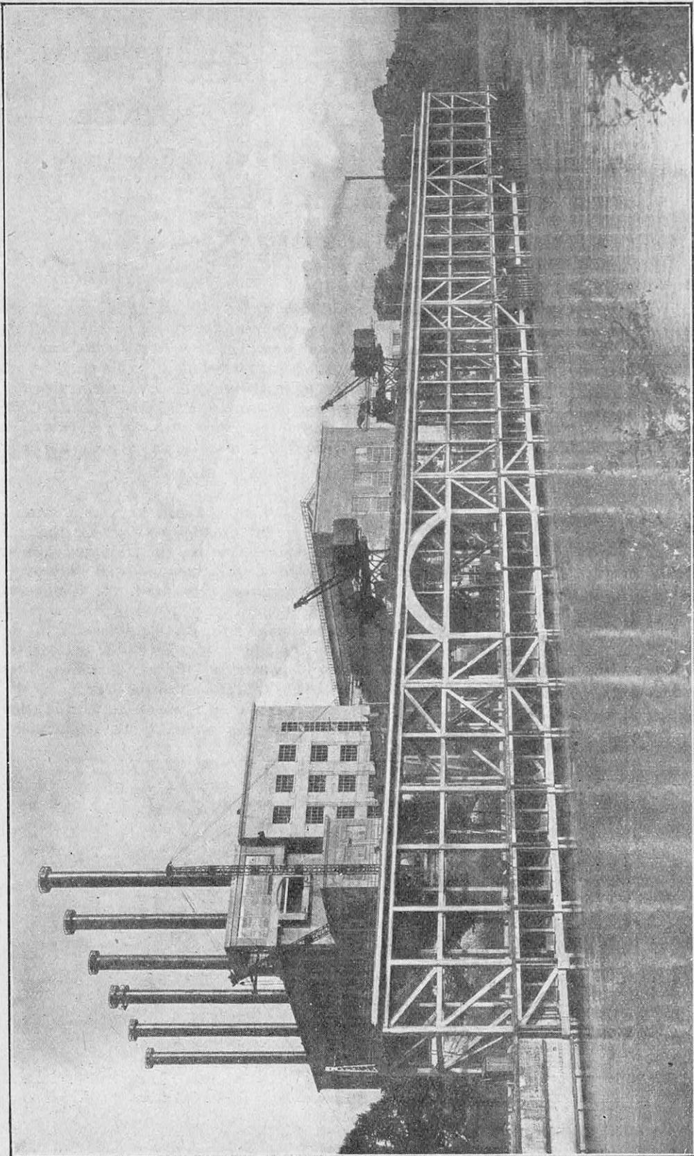
FIG. 2. — VUE GÉNÉRALE DE LA NOUVELLE CENTRALE DE SAINT-DENIS, PRÈS PARIS (DONT LA PUISSANCE ATTEINDRA 400.000 KILOWATTS), PRISE DE LA RIVE GAUCHE DE LA SEINE ET MONTRANT LES INSTALLATIONS EXÉCUTÉES POUR LE DÉCHARGEMENT DU CHARBON DES PÉNICHES
