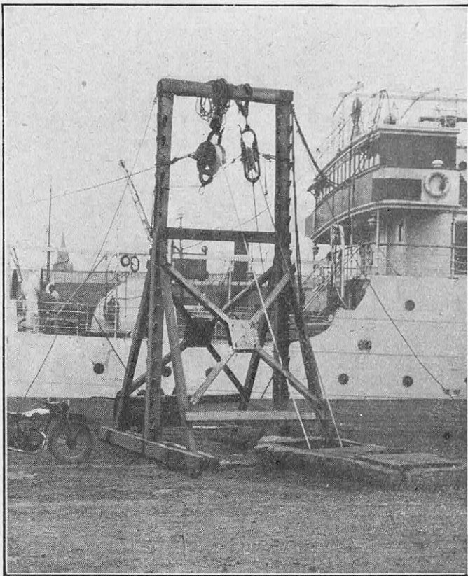
FIG. 5. — LE CHARGEMENT DU CÂBLE A BORD DU NAVIRE CABLIER « AMPÈRE »
