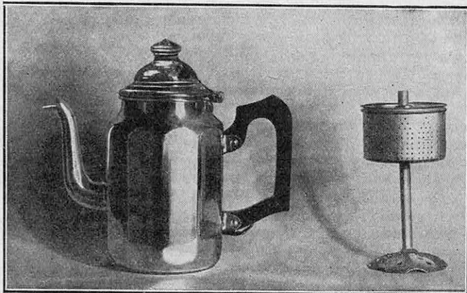
ENSEMBLE DE LA CAFETIÈRE AUTOMATIQUE. A DROITE, LE SYSTÈME INTÉRIEUR : TAMIS, TUBE, ETC.
