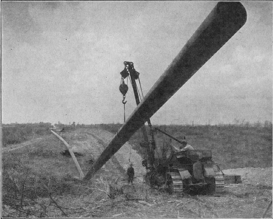
FIG. 6. — PAR OPPOSITION A LA PIPE-LINE SOUS-MARINE, VOICI COMMENT ON POSE UNE PIPE-LINE TERRESTRE, EN VIRGINIE (E.-U.)
