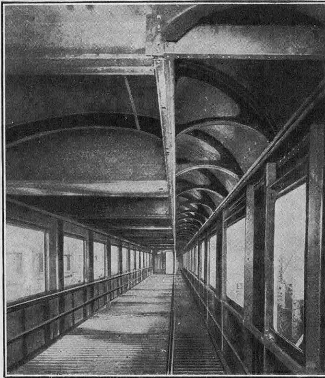
FIG. 7. — VOITURE DE LA COMPAGNIE DES WAGONS-LITS EN COURS DE MONTAGE
