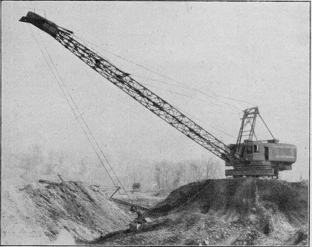
UN DES PLUS PUISSANTS « DRAGLINES » CONSTRUITS JUSQU'À CE JOUR, CAPABLE D'ENLEVER PRÈS DE 12.000 MÈTRES CUBES DE DÉBLAIS PAR JOUR.
