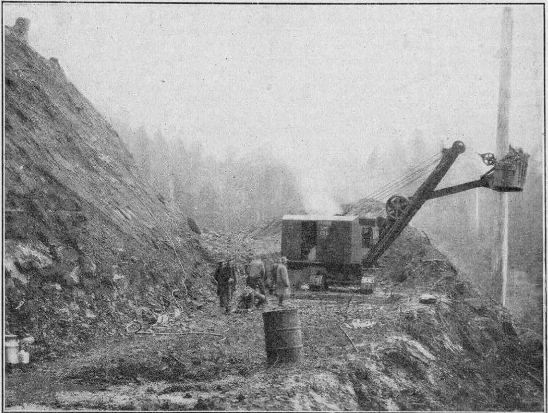
PELLE DRAGUEUSE DIESEL-ÉLECTRIQUE DE 1 MÈTRE CUBE, SERVANT A L'ÉTABLISSEMENT D'UNE PISTE, AUX ÉTATS-UNIS
