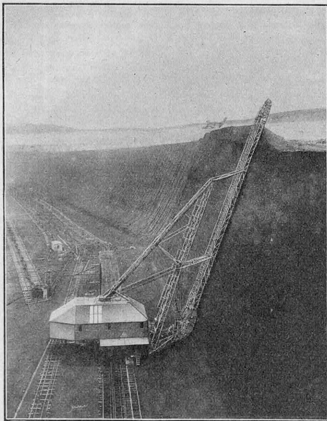
EXCAVATEUR RACLEUR DE 320 TONNES, CAPABLE D'EXTRAIRE, SUR 40 MÈTRES DE HAUTEUR, 900 MÈTRES CUBES DE LIGNITE A L'HEURE
