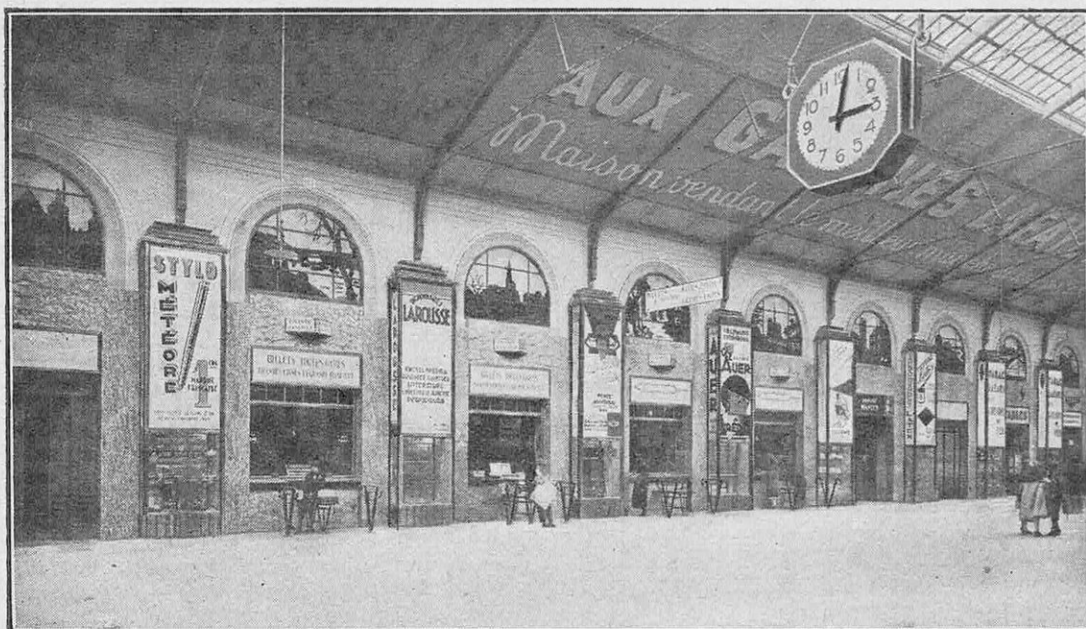
VUE D'UNE PARTIE DU GRAND HALL DE LA GARE SAINT-LAZARE A PARIS, MONTRANT LE DÉGAGEMENT PARFAIT DES GUICHETS ET L'ENSEMBLE DES NOUVEAUX AMÉNAGEMENTS
