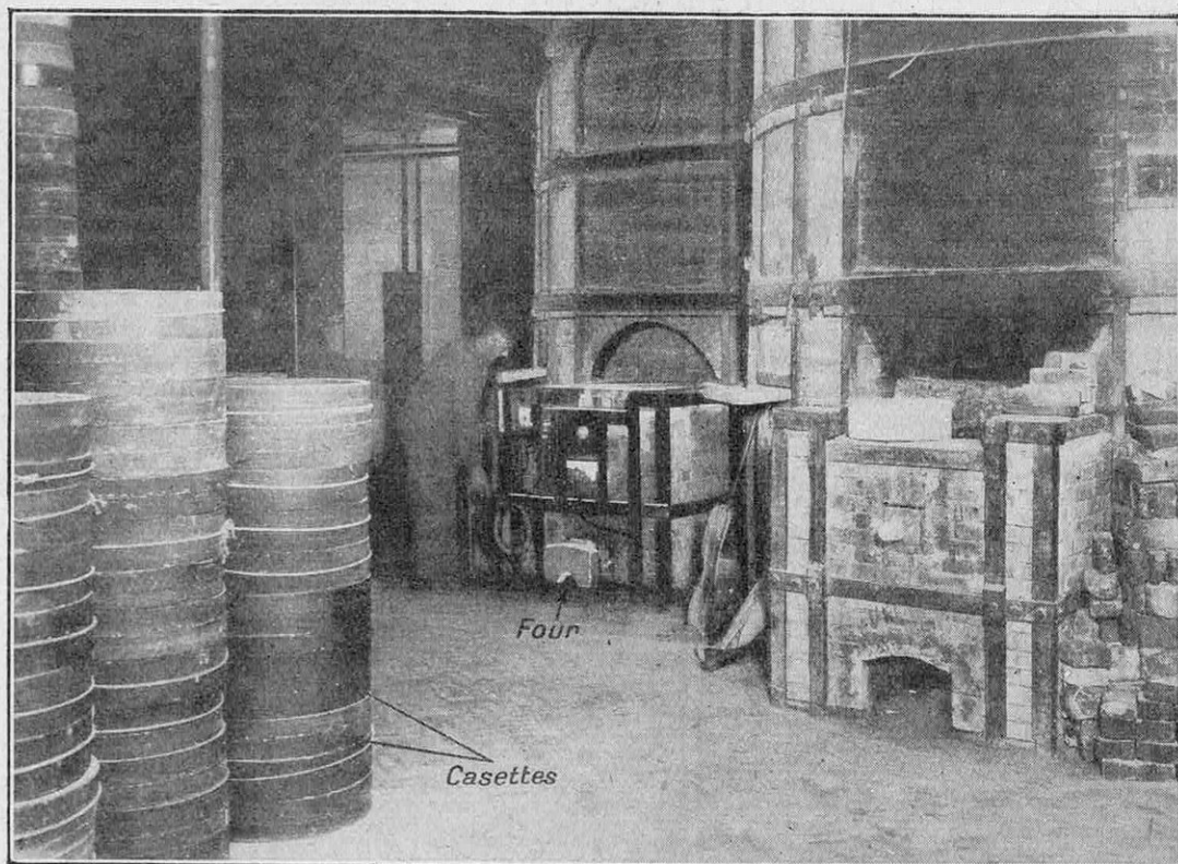
UNE BATTERIE DE GRANDS FOURS CHAUFFÉS AU MAZOUT
