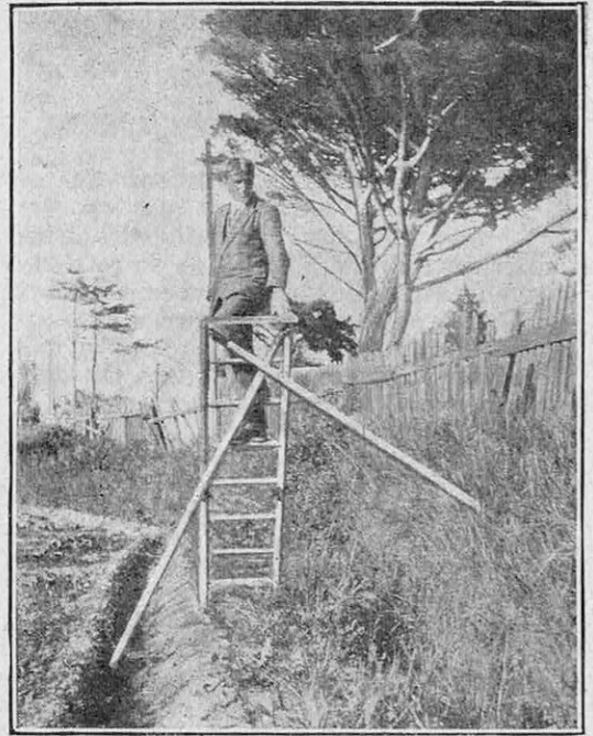
CETTE ÉCHELLE EST STABLE QUELLE QUE SOIT LA FORME DU TERRAIN SUR LEQUEL ON L'APPUIE
