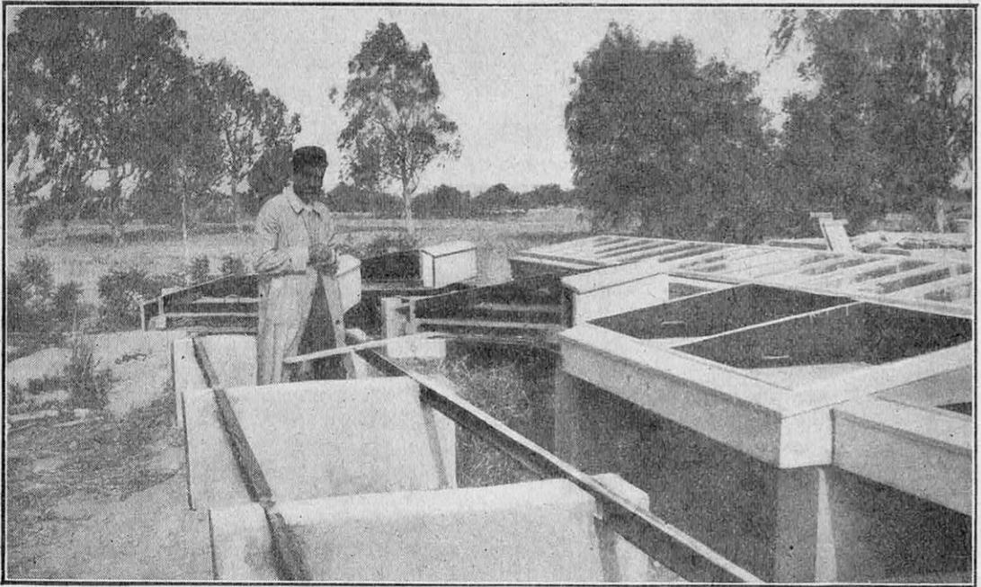
FIG. 4. — LES ÉLÉMENTS DE L'ÉPURATEUR DE BEN-GARDANE (TUNISIE) ONT ÉTÉ MONTÉS PAR GROUPE DE DEUX ET PLACÉS SUR DES MURETTES
