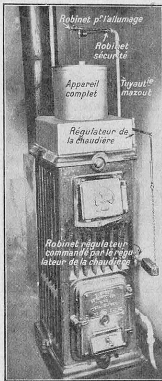
CHAUDIÈRE POUR LE CHAUFFAGE CENTRAL ALIMENTÉE AU MAZOUT
