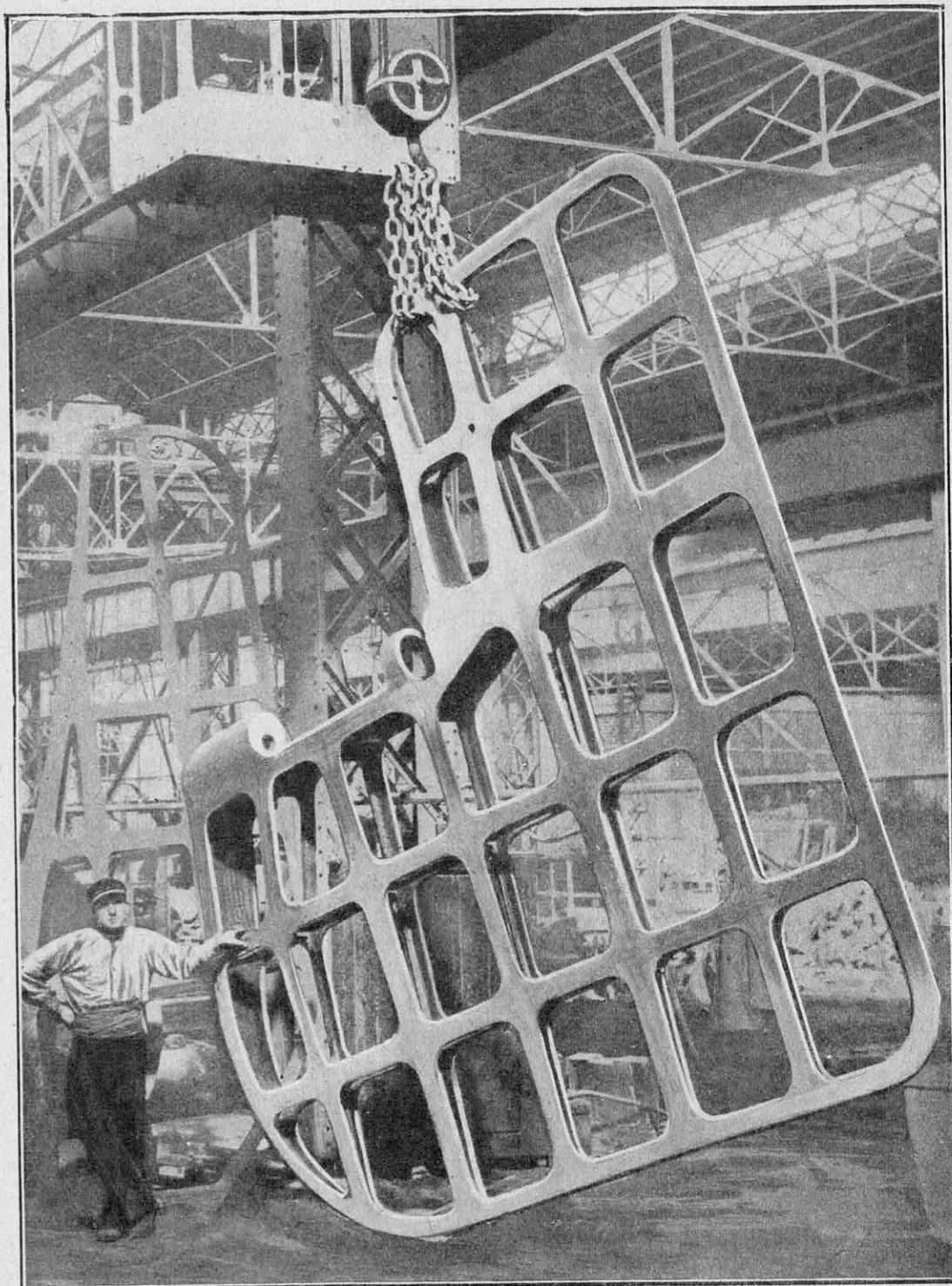
*Cette photographie représente l'ossature d'un gouvernail de sous-marin en acier doux coulé, obtenu au four électrique (1), aux usines d'Outreau. Cette ossature, de 4 mètres de haut environ, est établie avec des pièces de 10 millimètres seulement d'épaisseur, ce qui rend particulièrement délicate cette fabrication.*
