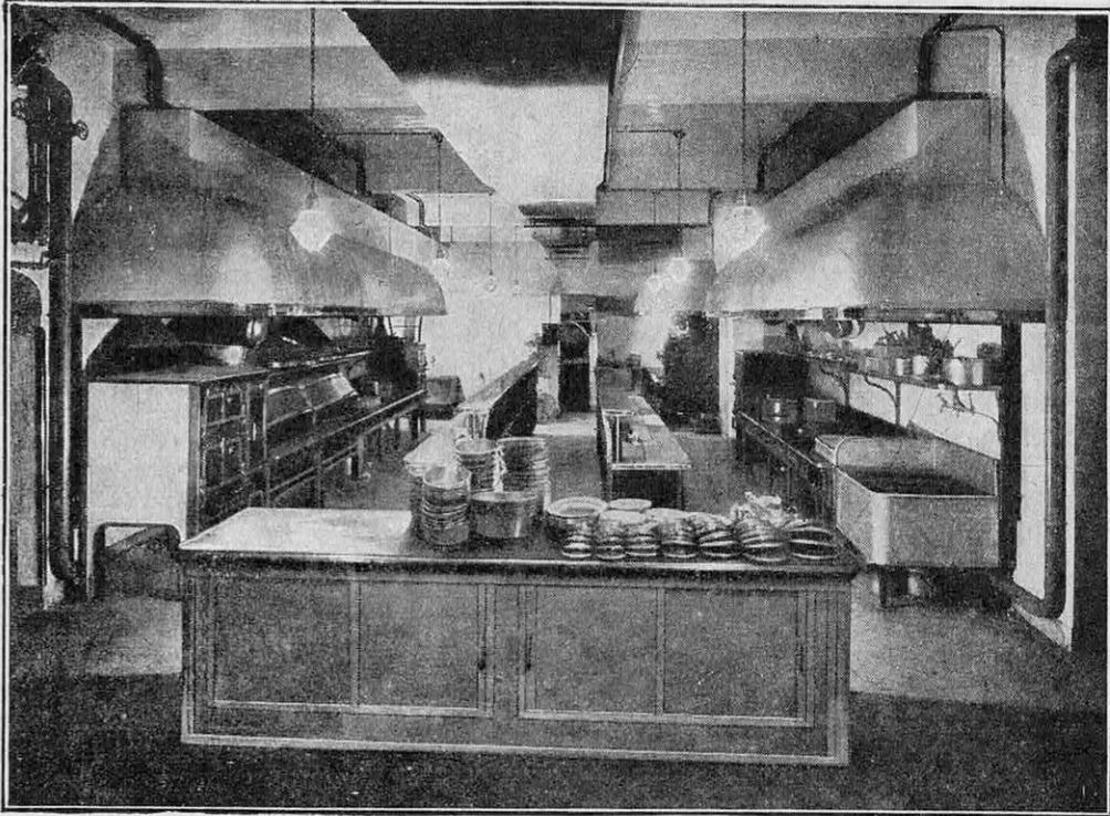
Installation complète de cuisine au gaz (Hôtel Moderne, Paris)
