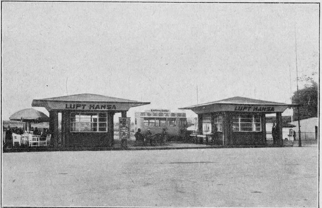
LES SALLES DU BUFFET DE L'AÉRODROME Les voyageurs y trouvent tout le confort désirable, été comme hiver.
