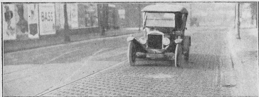
UN ESSAI DE REVÊTEMENT DE CAOUTCHOUC EN ANGLETERRE
