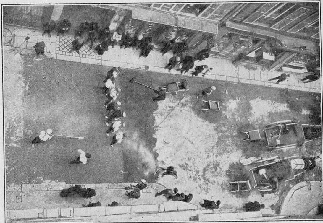
UN CHANTIER D'ASPHALTAGE A PARIS
