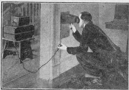
GRACE AUX RAYONS X, L'ÉLECTRICIEN PEUT, SANS DÉTÉRIORER LES MURS, VÉRIFIER LES CANALISATIONS QU'ILS RENFERMENT
