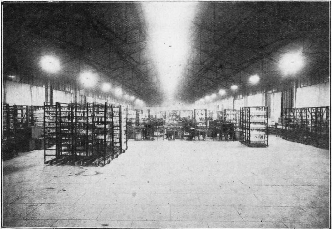
ÉCLAIRAGE GÉNÉRAL D'UN ATELIER AU MOYEN D'APPAREILS A RÉFLECTEURS
