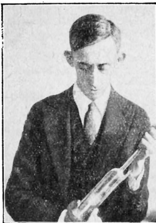
M. KUNSMAN ET SON NOUVEAU TUBE ÉMETTANT DES IONS AU LIEU D'ÉLECTRONS
