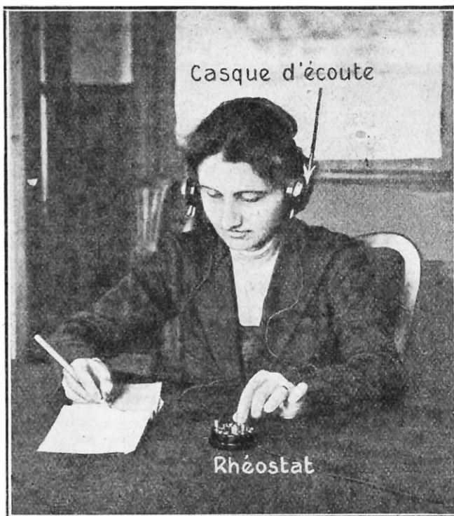
UNE STÉNOGRAPHE REÇOIT AU CASQUE D'ÉCOUTE, DANS SON BUREAU, TOUTES LES CONVERSATIONS TENUES À VOIX BASSE DANS UNE PIÈCE QUELCONQUE
