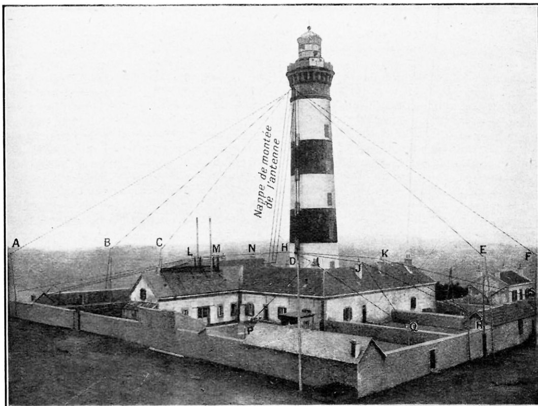
VUE GÉNÉRALE DE L'ANTENNE ET DU CONTREPOIDS DU RADIOPHARE D'OUESSANT
