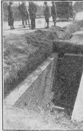
CHAMBRE SOUTERRAINE DESTINÉE A RECEVOIR LES BOITES CONTENANT LES BOBINES DE CHARGE
