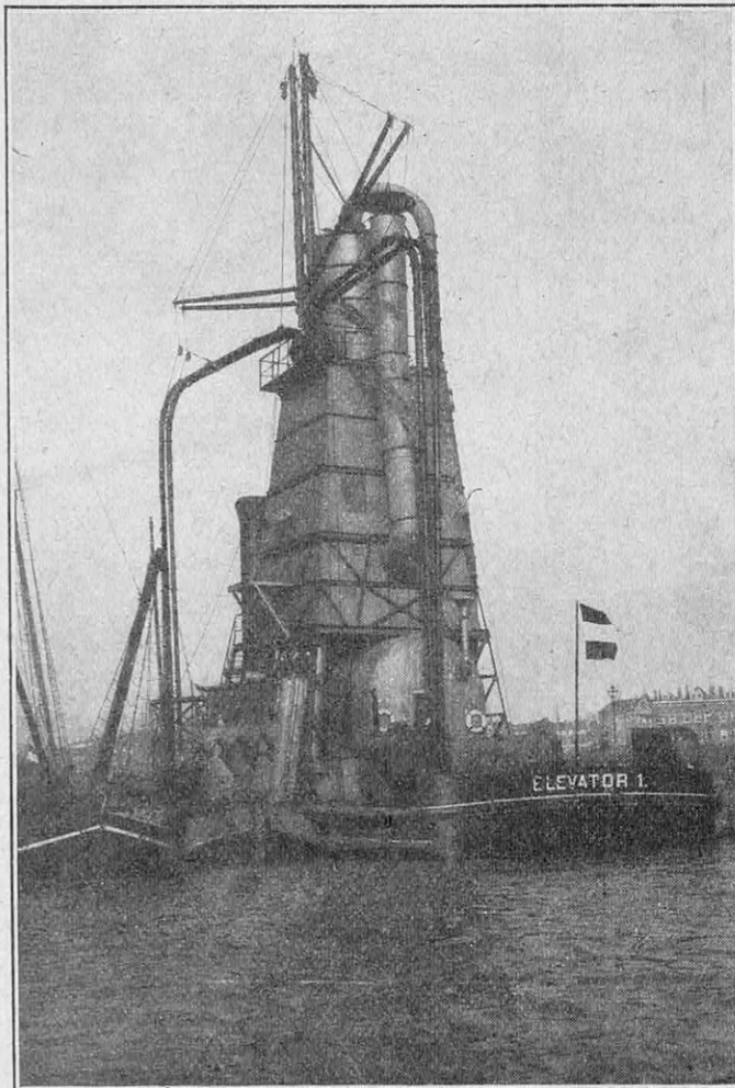
L'ÉLÉVATEUR PNEUMATIQUE ASPIRE RAPIDEMENT LE GRAIN CONTENU DANS LES FLANCS DU CARGO
