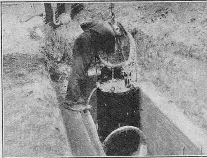
MISE EN PLACE D'UNE BOITE CONTENANT LES BOBINES DE CHARGE
