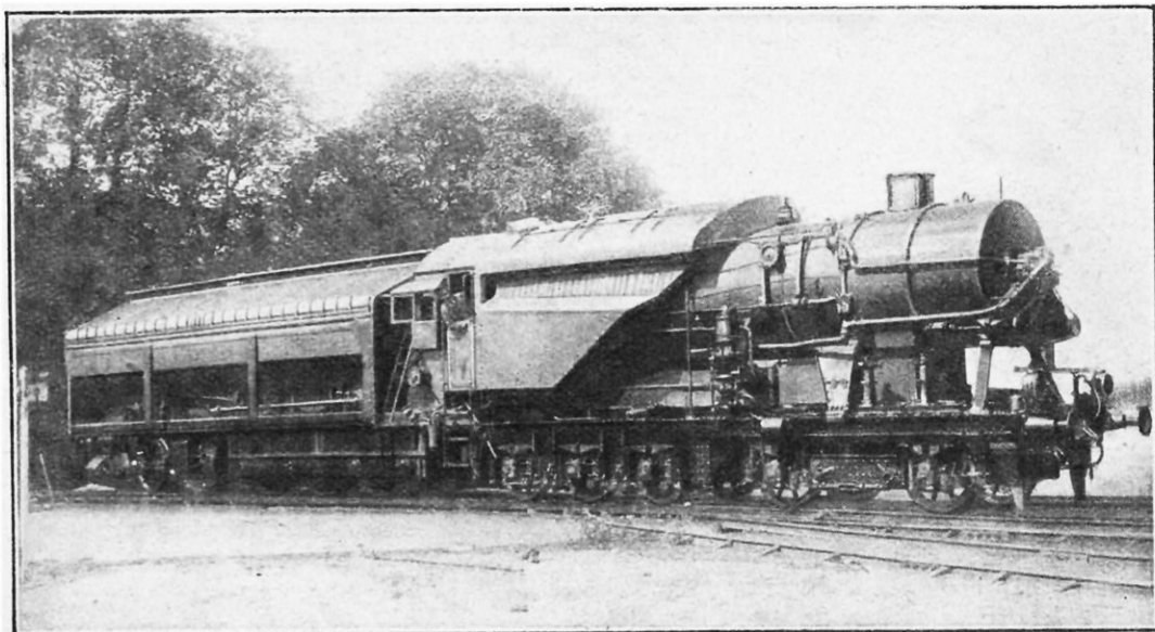
FIG. 11. - LA LOCOMOTIVE A TURBINES VA, PEUT-ÊTRE, DÉTRÔNER LA LOCOMOTIVE A PISTONS Nous voyons, ici, une locomotive à turbines «Ljungström», en service sur les chemins de fer suédois.
