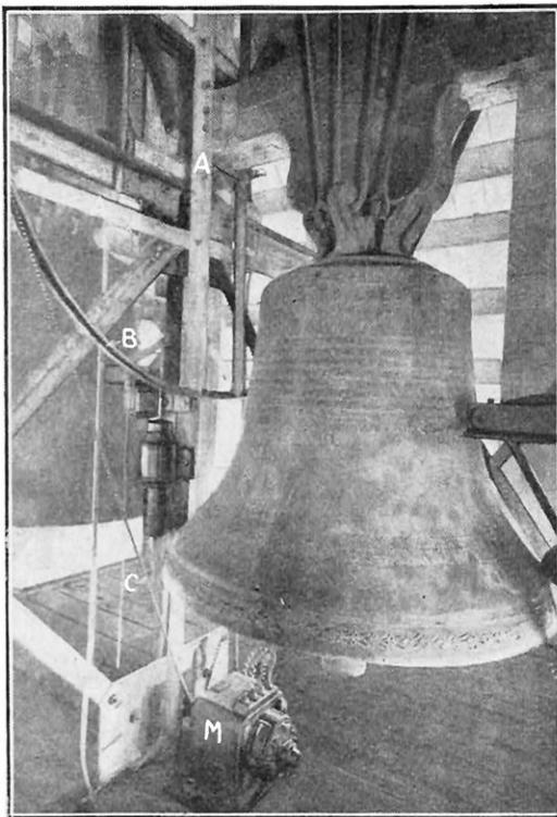
FIG. 1. — UNE CLOCHE ÉQUIPÉE POUR LA SONNERIE EN VOLÉE
