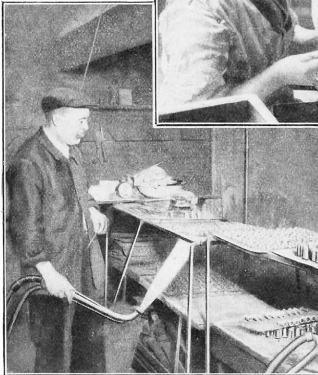
PLACÉES SUR DES GRILS MÉTALLIQUES, LES PIÈCES SONT SOUDÉES A L'AIDE DU CHALUMEAU
